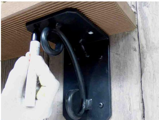
④シェルフフックの上に取り付ける棚板を乗せ、水平、位置を確認したあと、棚板裏面にビス穴位置の印をつけます。
