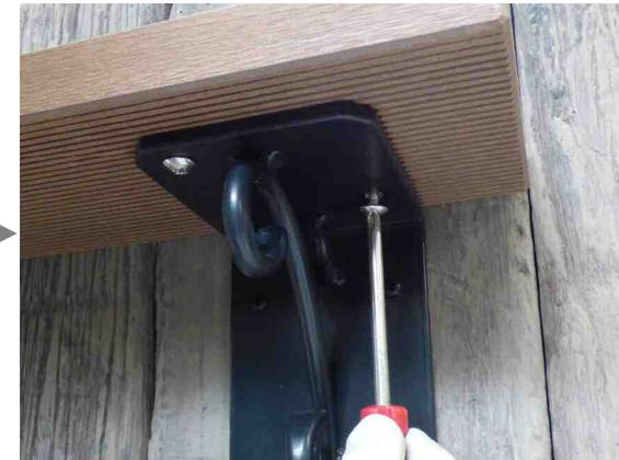
⑥棚板を付属のトラスビスで、ドライバーを用いて人力でねじ込み固定します。(強くねじ込むと、棚板側のねじ山がつぶれるので注意してください。)
