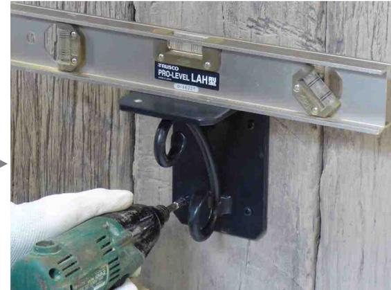
③穴内の切削粉を吹き飛ばした後、付属の黒色のコンクリートビスでねじ込み、固定します。(水準器を用いて位置を調整します。)
