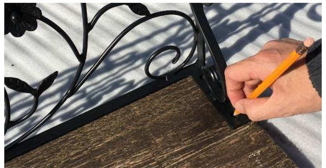
⑤ 天板は形状によって、破損しやすい箇所がありますので、丁寧に取り扱いください。オプションのチェックパネル、ロートアルミパネルを取り付ける場合は、養生シートの上で天板にパネルを置き、穴位置にしるしをつけ、天板の下に板などを当てて、8~10mmのコンクリートドリルで穴を開けておきます。(先に細いドリルでガイド穴を開けると正確に穴が開けられます。)
