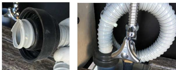
⑪反対側の先端をハサミ等でカットし、防臭キャップに差し込みます。臭いが上がってこないようにするため、排水管を一周ねじり、床面から出しておいた排水管に固定します。(写真のフレームは仕様異なります。)(次⑫へ)
