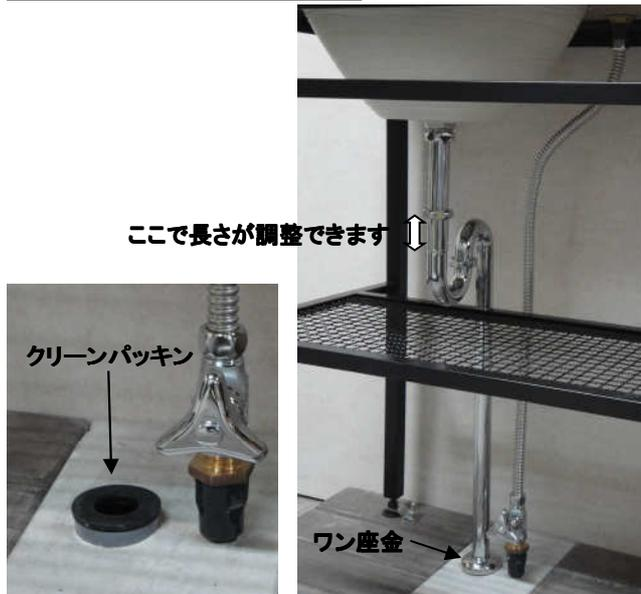
⑩⑪床面から出した排水管にクリーンパッキンを取り付けます。シンクを天板の穴に入れ、排水金具を取り付けます。写真のように排水パイプ(Sトラップ)を接続し、クリーンパッキンに3cmほど差し込める長さに排水パイプの下端をカットし、隙間がないように接続し、ワン座金をかぶせます。(ワン座金はあらかじめ排水パイプに通しておきます。)
