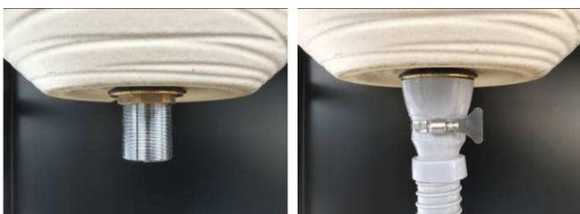
⑩シンクを天板の穴に入れ、排水金具を取り付けます。排水金具に排水パイプを差し込み、締め付け金具で抜けないように締め付けます。(丸型ステンシンクは排水金具付きで納品されます。)
