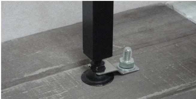
③ フレームを施工位置に置き、傾斜、凹凸、使用する方の身長(身長÷2+5cmが標準)に合わせて、水平になるようにアジャストボルトのねじ込み量を調整します。付属のアジャストボルト押さえ金具とアンカーボルトで固定します。(アンカーボルトは十分な荷重に耐えられるものを、施工する床材に応じて現場で手配してください。本体が動いたり、転倒したりすることがないように、しっかりと固定してください。)
