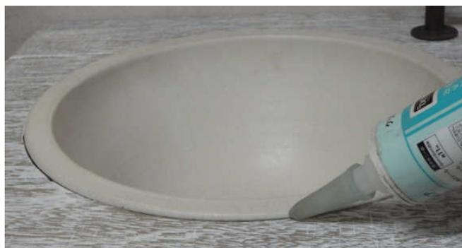
⑫シンクの周囲をマスキングテープで養生し、コーキングします。ベッセルシンクはシンクに付属の取扱説明書をご覧ください。ベッセルシンク付属の排水金具のゴム栓についているチェーンは使用しませんので取り外してください。ベッセルシンク、グローリーシンク、コーンシンク、丸型ステンシンクは、付属のゴミ取り網を排水金具に落とし込みます。
