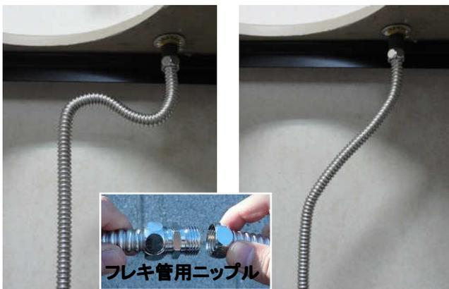
⑨給水管側と天板に取り付けたタップをフレキ管で接続します。フレキ管は手で曲げられますが、半径 50mm以上の緩やかなカーブで曲げます。また、継手の近くでは曲げないようにしてください。水漏れの原因になります。ラージシンクの場合は、フレキ管用ニップルで、フレキ管を接続して延長してください。左写真のようにフレキ管の長さが余ったときは、適当な長さでカットし、ツバ出し工具を用いてツバ出しを行い調整すると右写真のようにすっきりと仕上がります。
