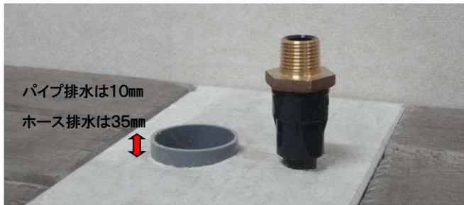
① バルブソケットをつけた給水管(HIVP-13)と、排水管(VU40、ラージシンク・ステンレスシンクのパイプ排水仕様は VU50)を施工図の位置に出しておきます。(現場調達品)
